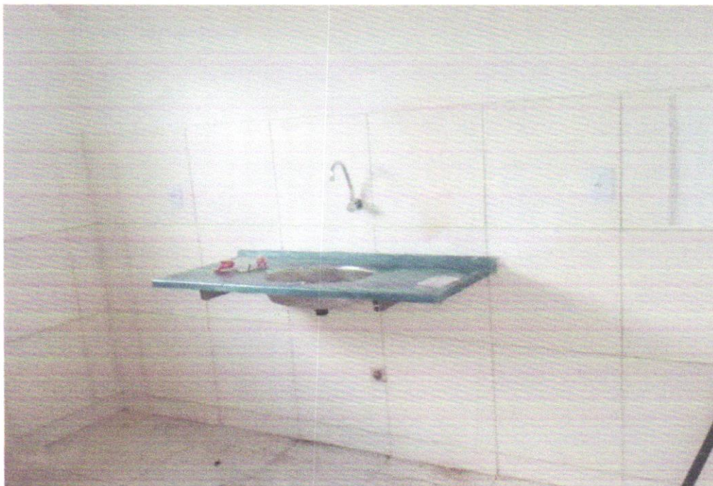
FOTO 05 – PIA DE COZINHA COM BANCADA EM AÇO INOX
