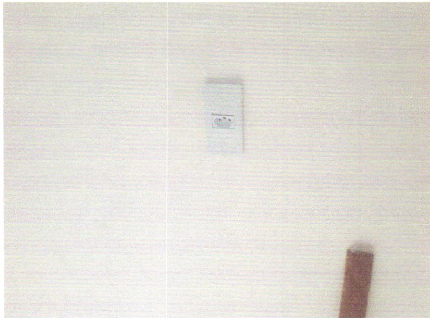
FOTO 03- TOMADA MÉDIA DE EMBUTIR (1 MÓDULO), 2P+T 10 A, INCLUINDO SUPORTE E PLACA - FORNECIMENTO E INSTALAÇÃO. AF_12/2015
