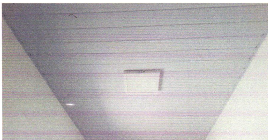
FOTO 01 – Forro de pvc, em régua de 10 ou 20 cín, aplicado, inclusive estrutura para fixação (perfis em PVC) marca Araforros ou similar, instalado - Rev 06-10/2021
